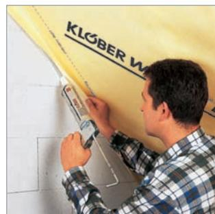
Vous traiterez l'étanchéité à l'air avec assurance et simplicité en utilisant selon les cas, soit le mastic colle Pasto® pour le raccord sur dalle maçonnée, pourtour de menuiserie etc., soit l'adhésif Permo® TR pour raccord entre lés.
